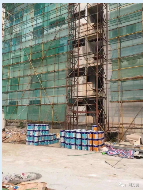
▲ 东莞长安某办公大楼
